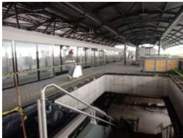
Instalação do corrimão e tratamento do concreto da Plataforma.
