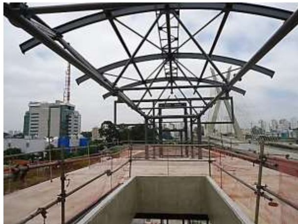
Instalação da cobertura metálica da Estação
