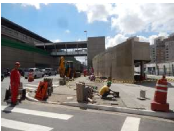
Assentamento do piso na região do Acesso Sul.
