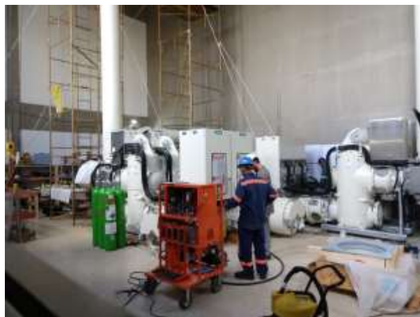
Montagem - Subestação Isolada a Gás
