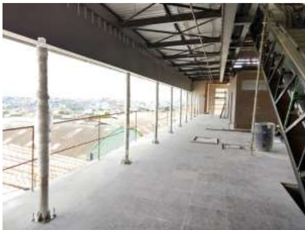
Instalação do guarda corpo do Mezanino.
